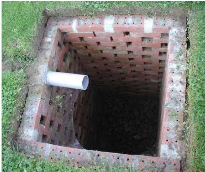
Ci-dessus : exemple de puisard d'infiltration
